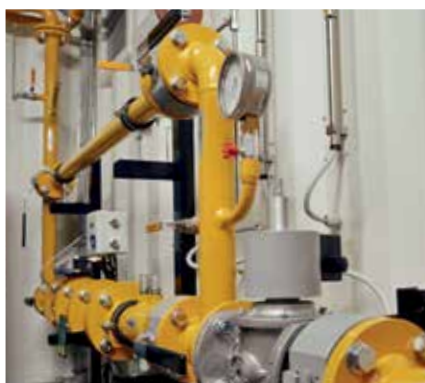
Linea di misura Metering system
