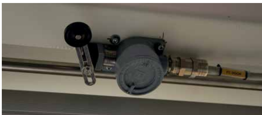
Sistema automatico di accensione luci interne all'apertura della porta ingresso Automatic system for turning on internal lighting when the entrance door is opened
