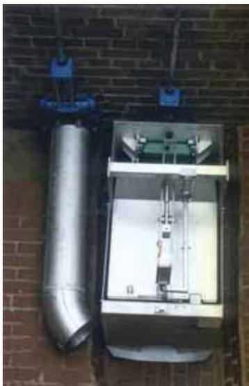
Los reguladores de caudal tipo flotador aseguran una regulación de aguas de lluvia y residuales con una curva de descarga vertical (caudal constante, independientemente del nivel de agua), sin requerir energía eléctrica.
