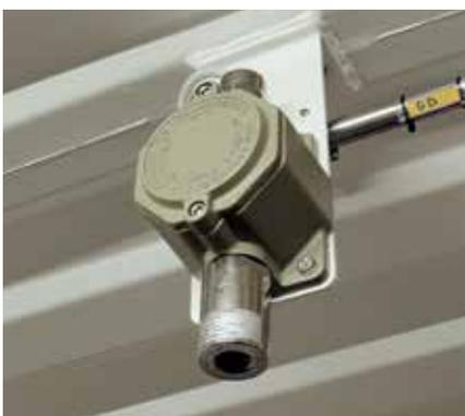
Rilevatore fughe gas
