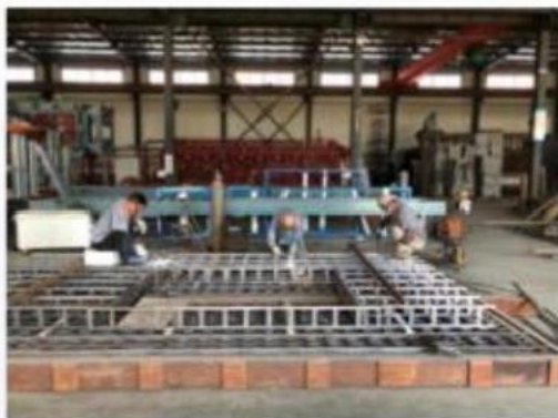
桁架、配筋组件
