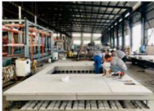
石墨烯EPS 模块安装
