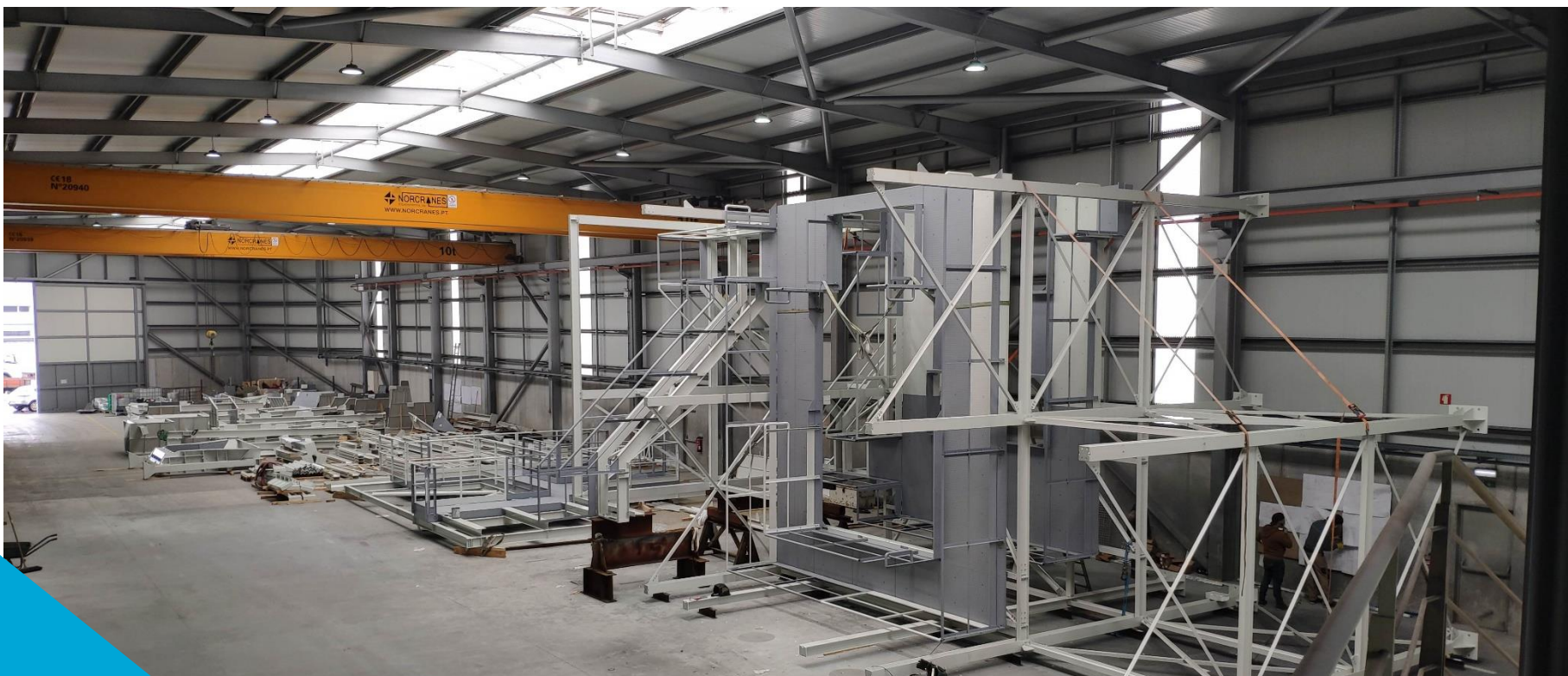
PROJECT: Estação de Crivagem e Britagem PLACE: Portugal
