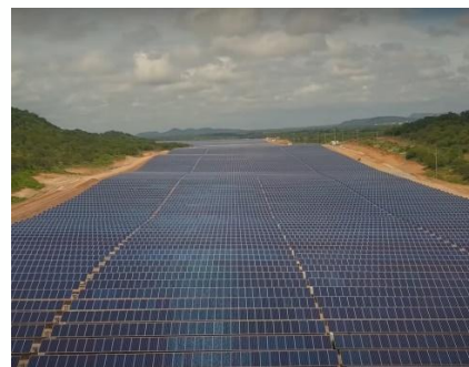
PV Futura 852 MW (Brazil)
