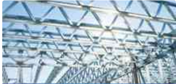
Çelik Konstrüksiyon Steel Construction
