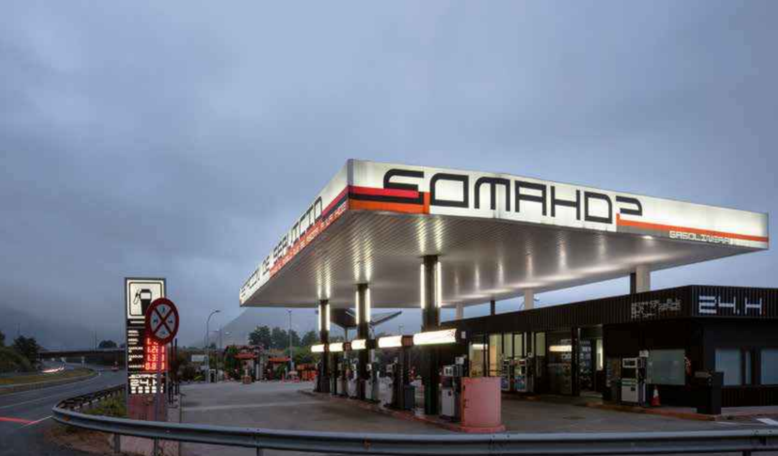
Estación de servicio, Los Corrales de Buelna (Cantabria), España - MMiT arquitectos. Javier Terán Alonso, Agustín Montes Gaisán, Alberto Montes Gaisán. Gas station, Los Corrales de Buelna (Cantabria), Spain Station-service, Los Corrales de Buelna (Cantabria), Espagne
