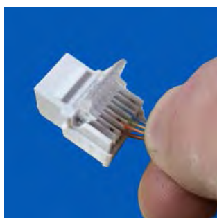
Posizionare i fili in corrispondenza dei contatti
