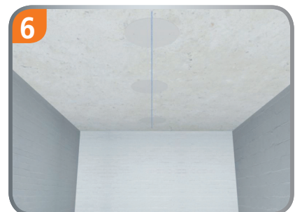
6 Fertigmontage: Fluchtlinie anzeichnen, Ungenauigkeiten können jetzt korrigiert werden.
