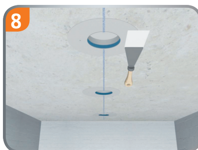
8 ...und an die Mineralfaserplatte angespachtelt...
