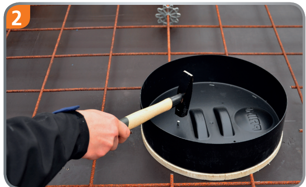
Bei Ortbeton auf Schalung nageln oder im Fertigteilwerk auf den Schaltisch kleben.
