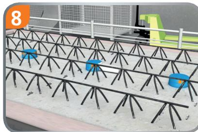
Stahlarmierung wird eingelegt und Beton gegossen.
