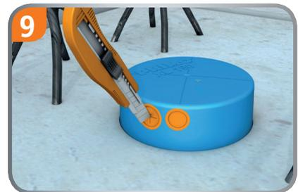
Membranöffnung mit Cuttermesser einschneiden.
