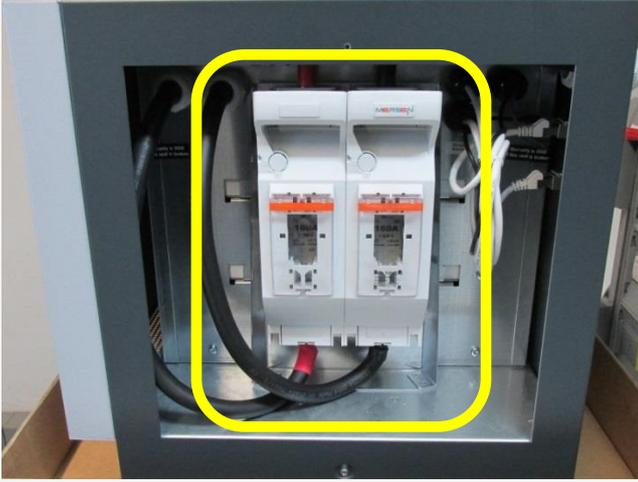
Abbildung 1-2 Batteriespeichersystem, Seitenansicht NH1 Trenner
