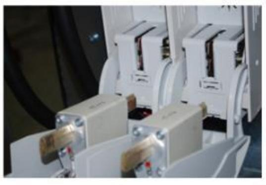
*Abbildung 4-8 Darstellung der korrekt eingelegten Sicherungen*
