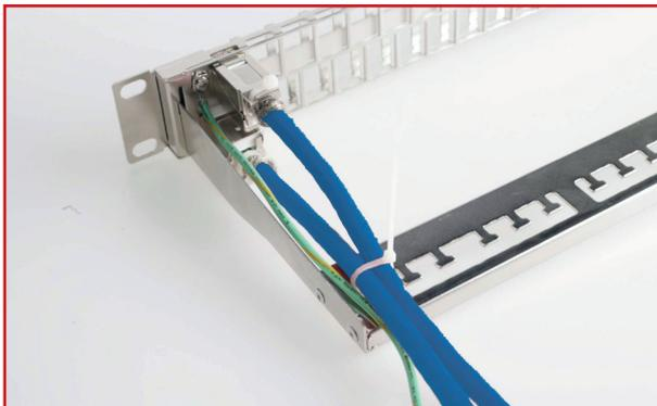
Je zwei Kabel mit einem Kabelbinder an der Kabelführung fixieren. Kabel nicht durch zu starken Druck beschädigen. /
