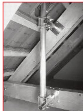
4. Den unteren Träger mittels einer Schraube im Langloch befestigen.
