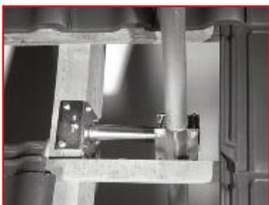
3. Den Mast am oberen Träger handfest befestigen, ausrichten und auf passende Länge nach unten achten. VDE Vorschriften beachten! Einspannlänge / Nutzlänge
