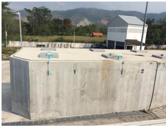
ภาพที่ ๓ ถังหมักย่อยสลาย ความจุ ๔๐ ลบ.ม./ถัง
