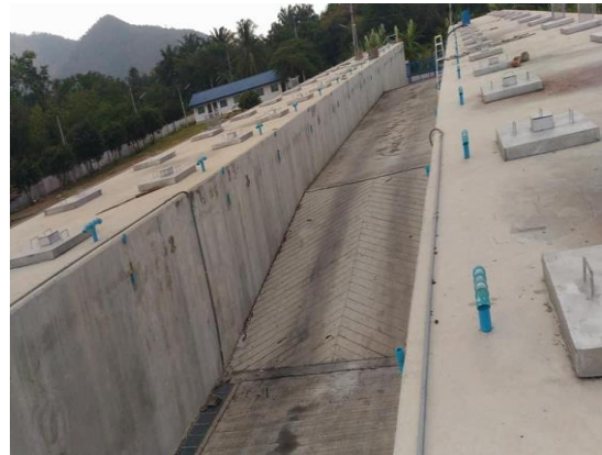
ภาพที่ ๓ ถังหมักย่อยสลาย ความจุ ๔๐ ลบ.ม./ถัง
