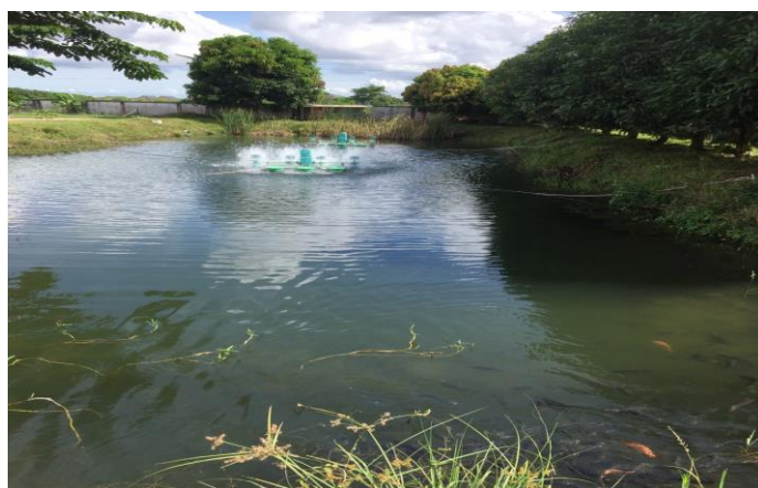
ภาพที่ ๗ บ่อบำบัดน้ำเสีย
