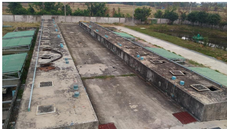
ภาพที่ ๔ ถังหมักย่อยสลาย ความจุ ๕ ลบ.ม./ถัง
