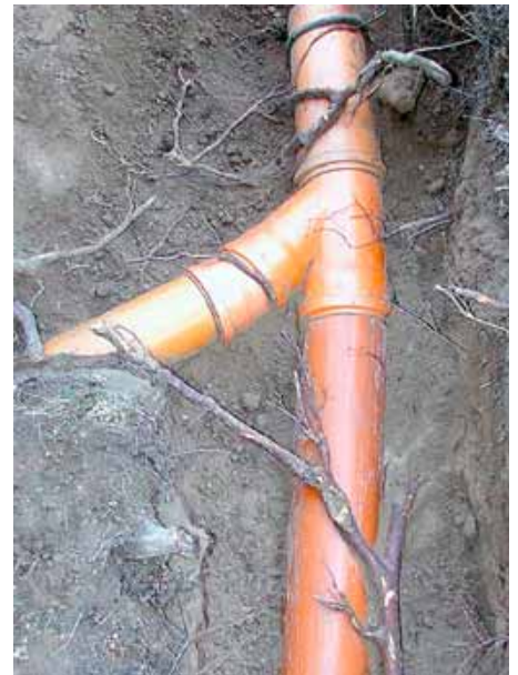
Abb.2: Ein wiederkehrendes Bild bei Aufgrabungen im Gehwegbereich. Wurzeln wachsen nach dem Eintritt in den Leitungsgraben parallel zum Kanal und geraten mit der Leitung in Kontakt. | Foto: Heiko Schmiedener
