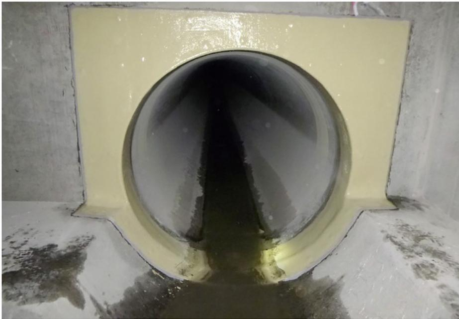
Nach Sanierung der Schächte und Verlegung der GFK-Rohre wurden die Schachtanschlüsse anlaminiert. | Foto: Aarsleff Rohr-sanierung
