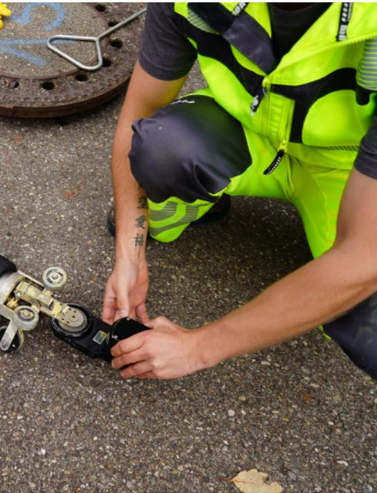
Um den Schwalm-Packer zum einzubindenden Anschluss zu schieben und korrekt zu positionieren, wird er über den Hutprofil-Adapter an den MicroGator gekoppelt. | Fotos: IBAK
