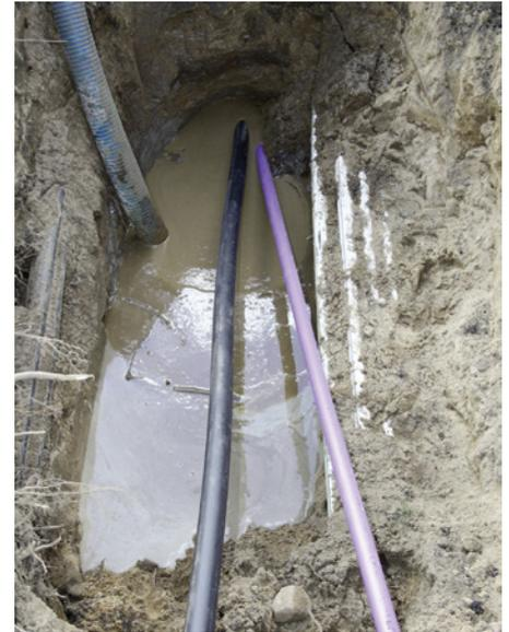
Problemlos werden die beiden Rohrstränge PE-HD DA 50 und Multipipe DA 50 (24x5) gleichzeitig eingezogen.
