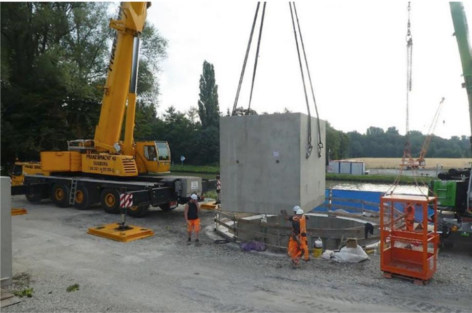
Die Anlieferung der Fertigteile von Firma Kleihues für die Ein- bzw. Auslaufbauwerke des Grael-Dükers am Dortmund-Ems-Kanal in Münster erfolgte mit einem schweren Mobilkran.
