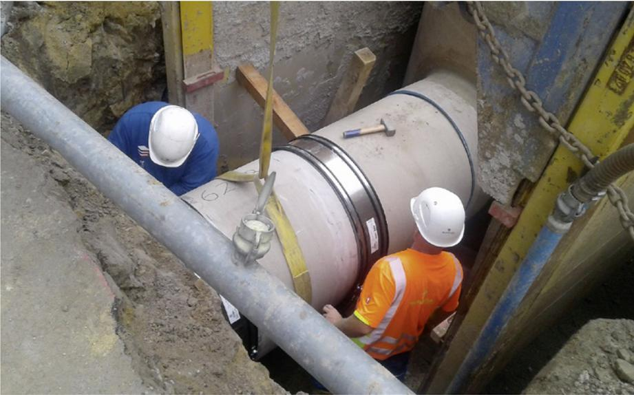
Einbau eines Passstücks zwischen vorhandenem Kanal GFK-Eiprofil 800/1200 und Gelenkstück | Foto: Eurovia VBU
