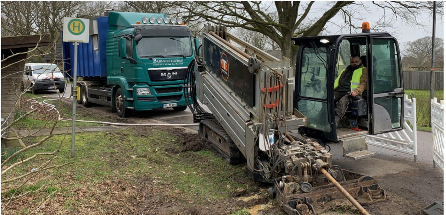
Entsprechend seiner kompakten Bauweise braucht der Grundodrill 15XP nur wenig Platz. Alles ist in Position gebracht, die Pilotbohrung kann starten.
