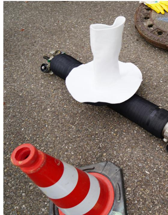
Die Kuchler GmbH nutzt den Fräsroboter MicroGator in Ulm unter anderem 1) für vorbereitende Fräsarbeiten vor Schlauchliner-Einzug (hier Muffenversatz glätten), 2) zum Öffnen der Zuläufe nach Schlauchliner-Einzug, 3) für das Hutprofilsetzen vorbereitende Fräsarbeiten (hier das Anrauen der Zuläufe mit dem Stahlbürsten-Aufsatz), 4) zum Einführen, Positionieren und Entfernen des Hutprofil-Packers.
