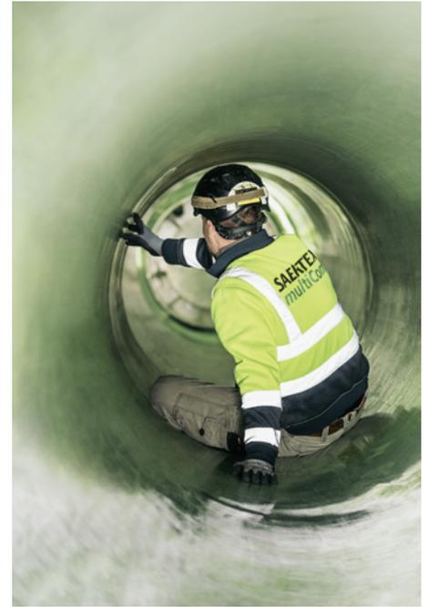
Aktuelles Entwicklungsziel bei Saertex multiCom ist es, den Einbau der Liner einfacher, sicherer und schneller zu gestalten. | Foto: Saertex multiCom
