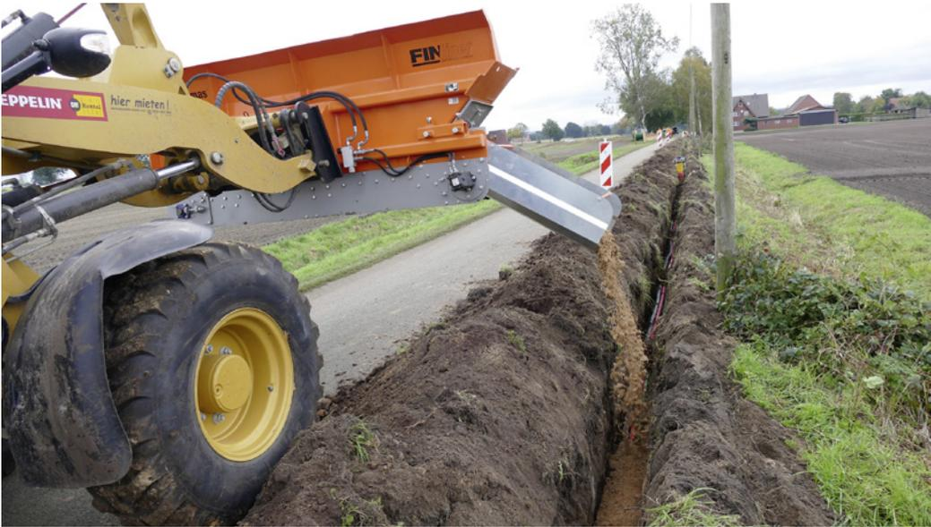
Die Material-Verteilschaufel „Finliner“ von Optimas sandet die Rohrleitungen gleichmäßig und zügig ein. Gestreut wird seitlich, während der Radlader geradeaus fährt. | Fotos: Optimas
