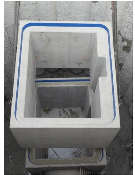
Präzisionsarbeit: Das Dükerrohr passt genau in die vorgesehene Öffnung des Stahlbetonrahmens. Praktischerweise können die Bauteile aufeinander gestapelt werden.
