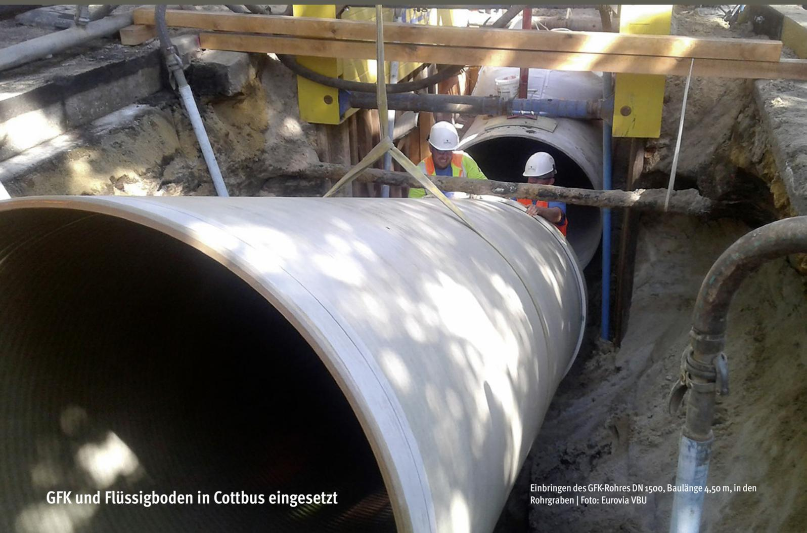
GFK und Flüssigboden in Cottbus eingesetzt
