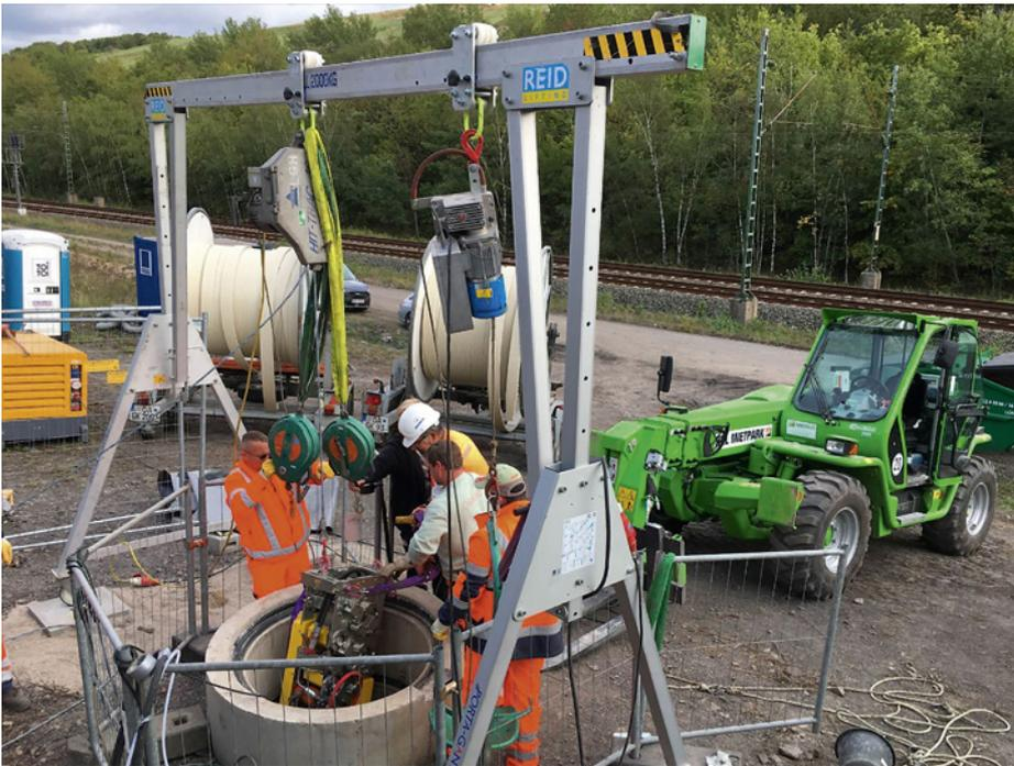
Über den Schacht, der 13 Meter in die Tiefe führte, wurde das Wickelrohr in den Kanal eingezogen. | Fotos: Geiger Kanaltechnik
