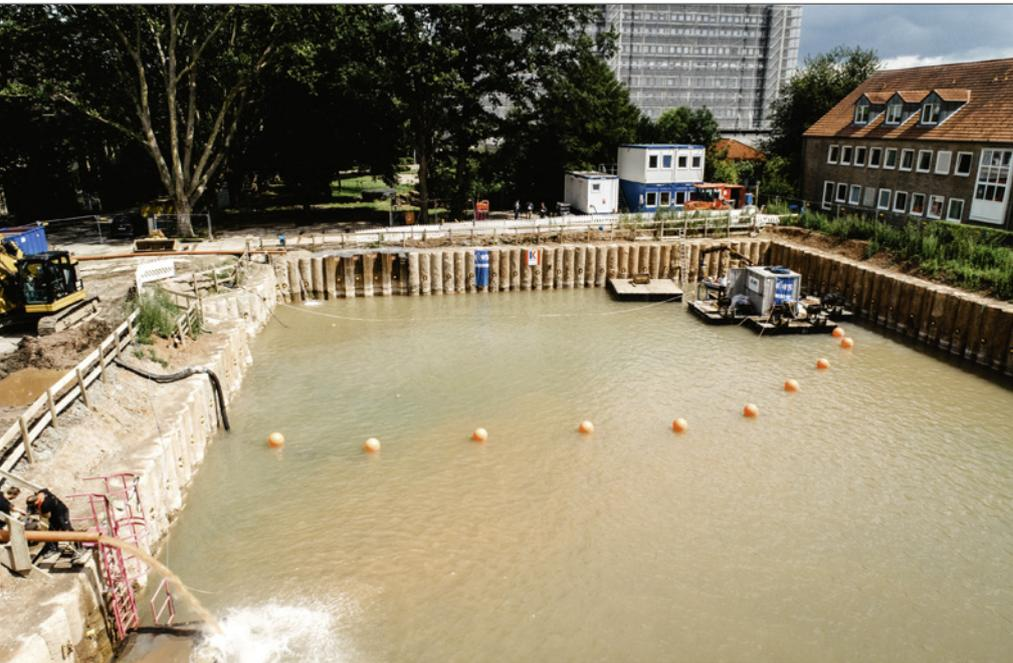
Neues Regenrückhaltebecken in Bielefeld: Taucher pumpen Zement und Schlamm vor dem Einbau der Unterwasserbetonsole aus dem Becken. Oben rechts der Taucherponton, links der Zu- und Rückfluss der Absetzbecken.
