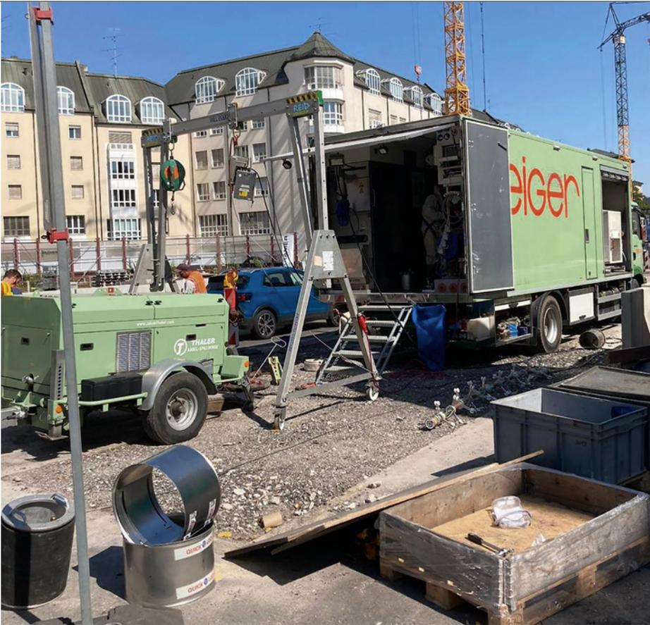
Beim Bau der dreistöckigen Tiefgarage in Münchens Altstadt konnte die Geiger Kanaltechnik innerhalb von zwei Tagen einen rund 145 m langen beschädigten Kanal sanieren.
