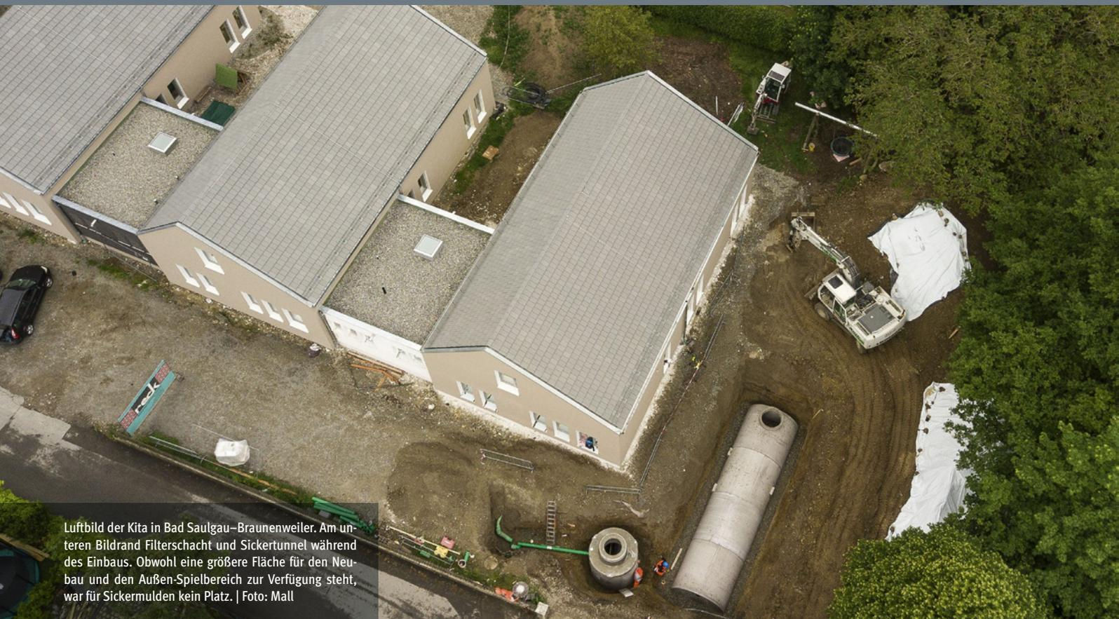
Luftbild der Kita in Bad Saulgau–Braunenweiler. Am unteren Bildrand Filterschacht und Sickertunnel während des Einbaus. Obwohl eine größere Fläche für den Neubau und den Außen-Spielbereich zur Verfügung steht, war für Sickermulden kein Platz. | Foto: Mall
