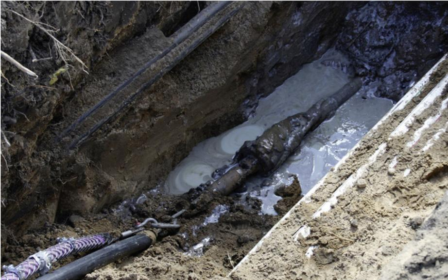
Die bereitliegenden Rohrstränge sind an den Backreamer gekoppelt und werden beim Rückzug in den Bohrkanal eingezogen.
