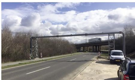
Abb. 13: Überbrückung der L 257 mit der Rückspülleitung
