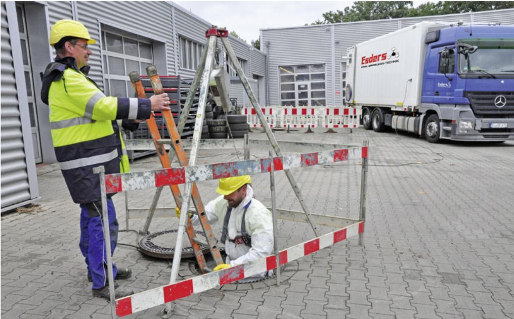
Dichtheitsprüfung und Sanierung des Leichtflüssigkeitsabscheiders (Ölabscheider) bei einem Autohaus in Haselünne | Fotos: Esders GmbH
