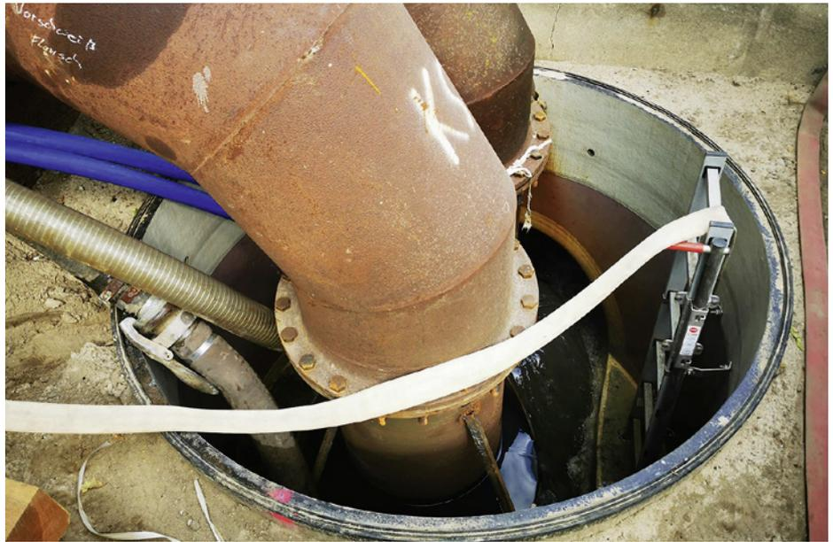
Der Auslauf der Abwasserumleitung Stahl DN 600 in den GFK-Schacht DN 2000 | Foto: Amiblu
