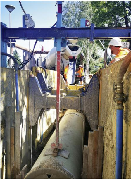
GFK-Rohr DN 1200, eingespannt in der Verlegehilfe kurz vor Einbringung des Flüssigbodens | Foto: Amiblu
