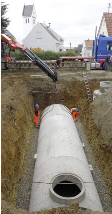
Nach dem Versetzen des Sickertunnels CaviLine und vor der Verfüllung werden die gerundete Oberseite mit Geotextil abgedeckt, der Domschacht für den Einstieg bis zur Geländehöhe aufgesetzt und die Zulaufleitung vom Filterschacht zum Sickertunnel verlegt. | Foto: König
