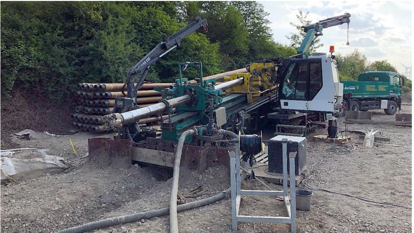
Abb. 15: 100-t-Bohranlage PD 100/50 RP
