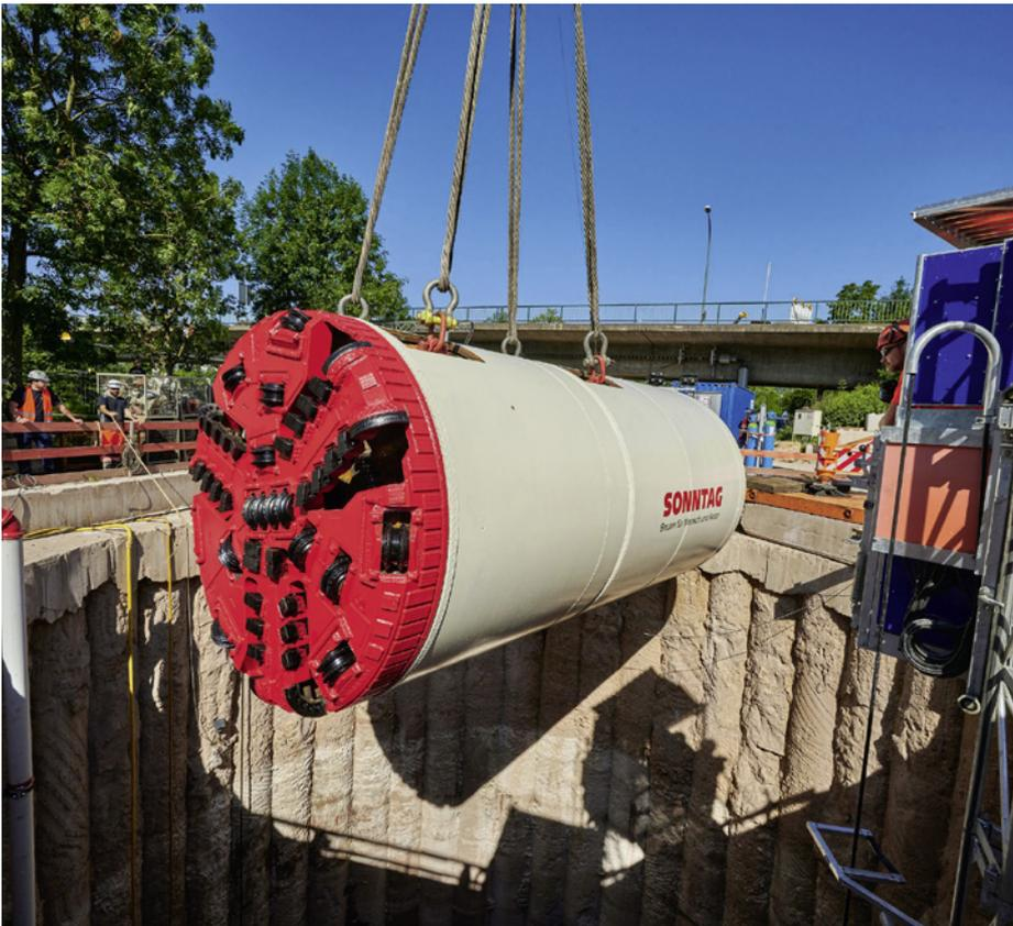
Der 95 to schwere Bohrkopf wird in die Startgrube gehoben. | Fotos: Sonntag Baugesellschaft
