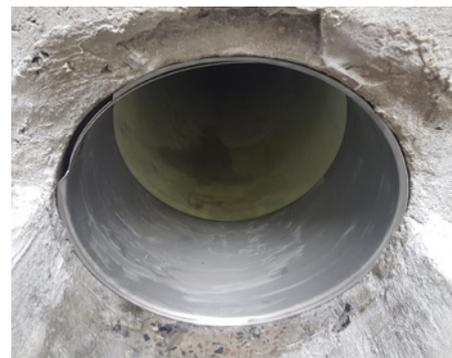
Die Anbindung der Liner an die Schächte erfolgte mit Linierendmanschetten von Uhrig. Eingebaut wurden fast 300 Stück.
