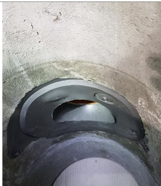
Mit Willpox SP, dem 2-Komponenten-Epoxidharz zur Kalt- & Warmaushärtung mit guter Haftung auch an feuchten Oberflächen, entsteht nach dem Aushärten ein vollplastisch wiederhergestellter Stützen, der von einem neuen Bauteil kaum zu unterscheiden ist.
