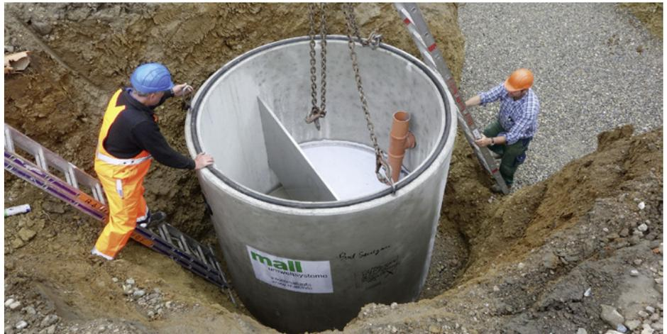
Versetzen des Filterschachts ViaPlus vom Kran des Lieferfahrzeugs in die vorbereitete Baugrube. Die Abmessungen der Schachtbauteile erlauben einen preiswerten Transport vom Hersteller zum Einbauort, ohne Sondergenehmigung. Einbauteile und Rohrdurchführungen sind ab Werk schon integriert. | Foto: König
