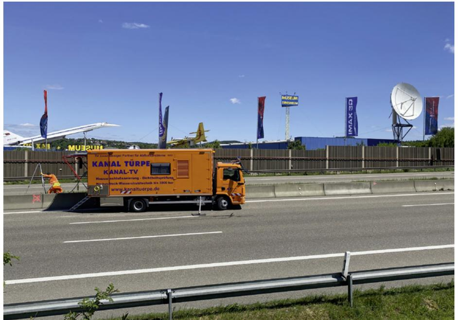
Waren die Arbeiten in einem Sanierungsabschnitt fertig gestellt, wurde eine abschließende TV-Abnahme durchgeführt. | Fotos: Kanal-Türpe
