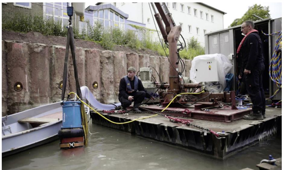
Die Briloner Spezialisten bereiten den „Staubsauger des Bauttauchers“ auf den Einsatz vor. Gut sichtbar der selbst erstellte Anschluss des Saugrüssels. Im Hintergrund der noch saubere Schlauchabgang.
