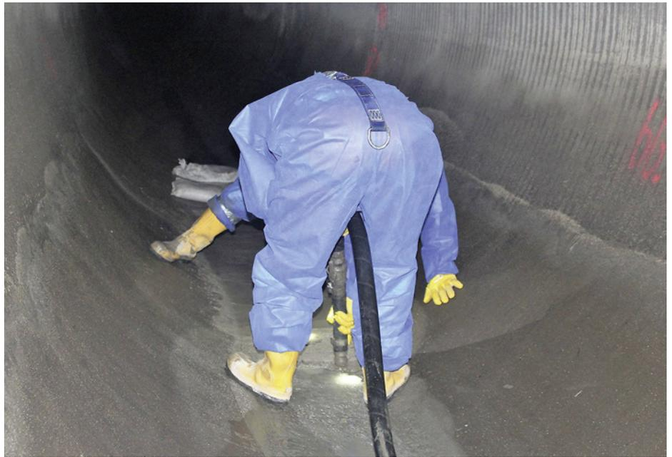
Die Beschichtung und die Reprofilierung des Sohlbereiches erfolgte von Hand. Der mit Wasser angemischte ombran MHP-SP Mörtel wurde in den Kanal gepumpt. | Foto: MC-Bauchemie
