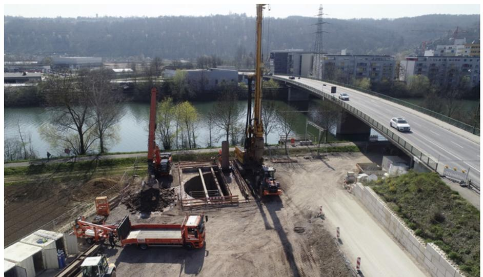
Parallelarbeit in Perfektion. Während die letzten Aushubbohrungen durchgeführt werden, kann der Hitachi ZX 350LC-6 TS mit Teledipper das lockere Material unter Wasser ausheben.
