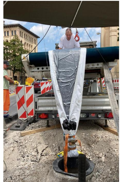
Mit Hilfe einer Winde wurde der Inliner durch die Schächttöffnung in den Schacht bis zur sanierenden Haltung gezogen. Aufgrund des Gewichts von 2.900 kg wurde der Liner mit einem Förderband eingebaut. | Fotos: Geiger Kanaltechnik
