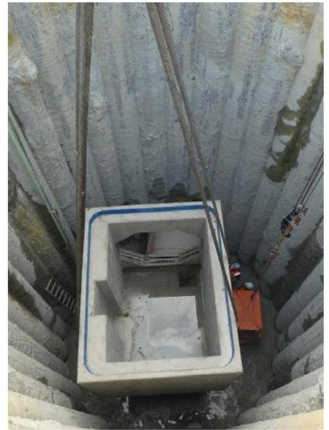
Einsetzen des ersten Stahlbetonfertigteils in den etwa 11 m tiefen Schacht
