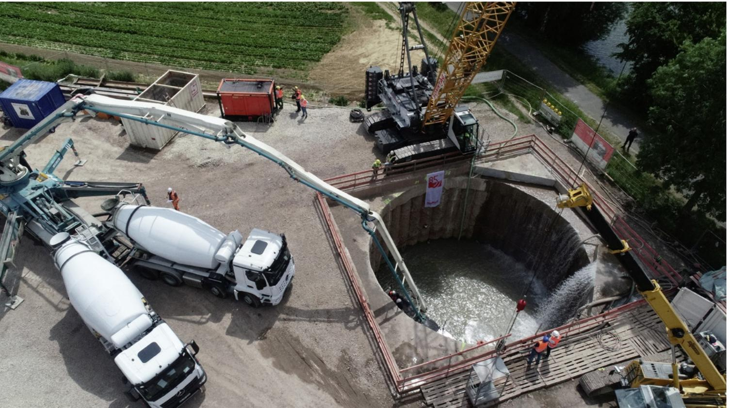
Unterwasserbetonage der Startgrube. 283 cbm Beton wurden in 8 Stunden eingebaut.
