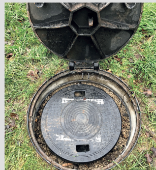
Dichtfunktion durch PE-Deckel DN 625 verhindert das Eindringen von Wasser, auch in Überflutungsbereichen
