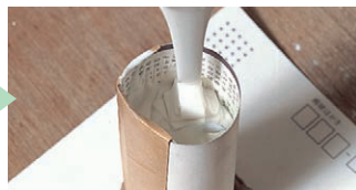
②ししとうの周囲を型枠で囲い、底板に固定し、シリコーンが漏れないようにふさがり流し込みます。
