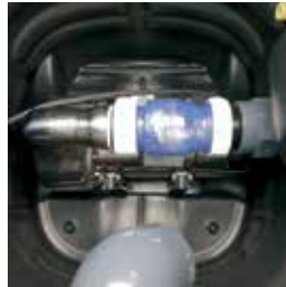
Rückschlagventil RSK und Entleerungspumpe
