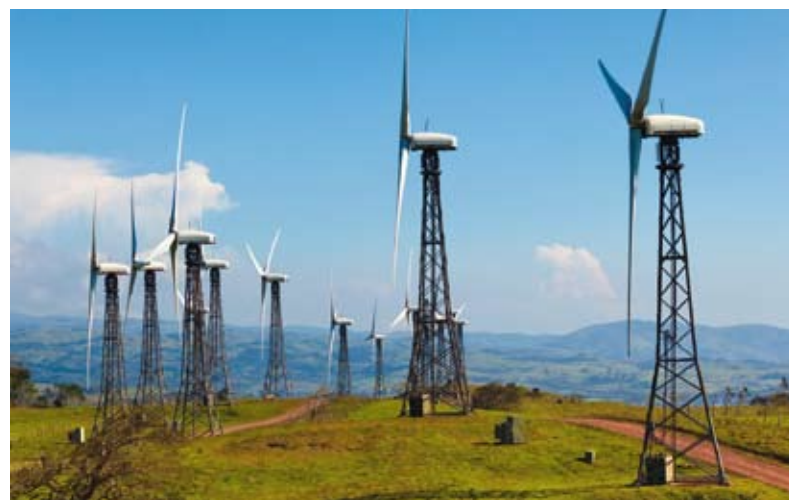
VĚTRNÍKY. Kostarika loni dokázala žít 75 dní v kuse jen z energie z obnovitelných zdrojů.
