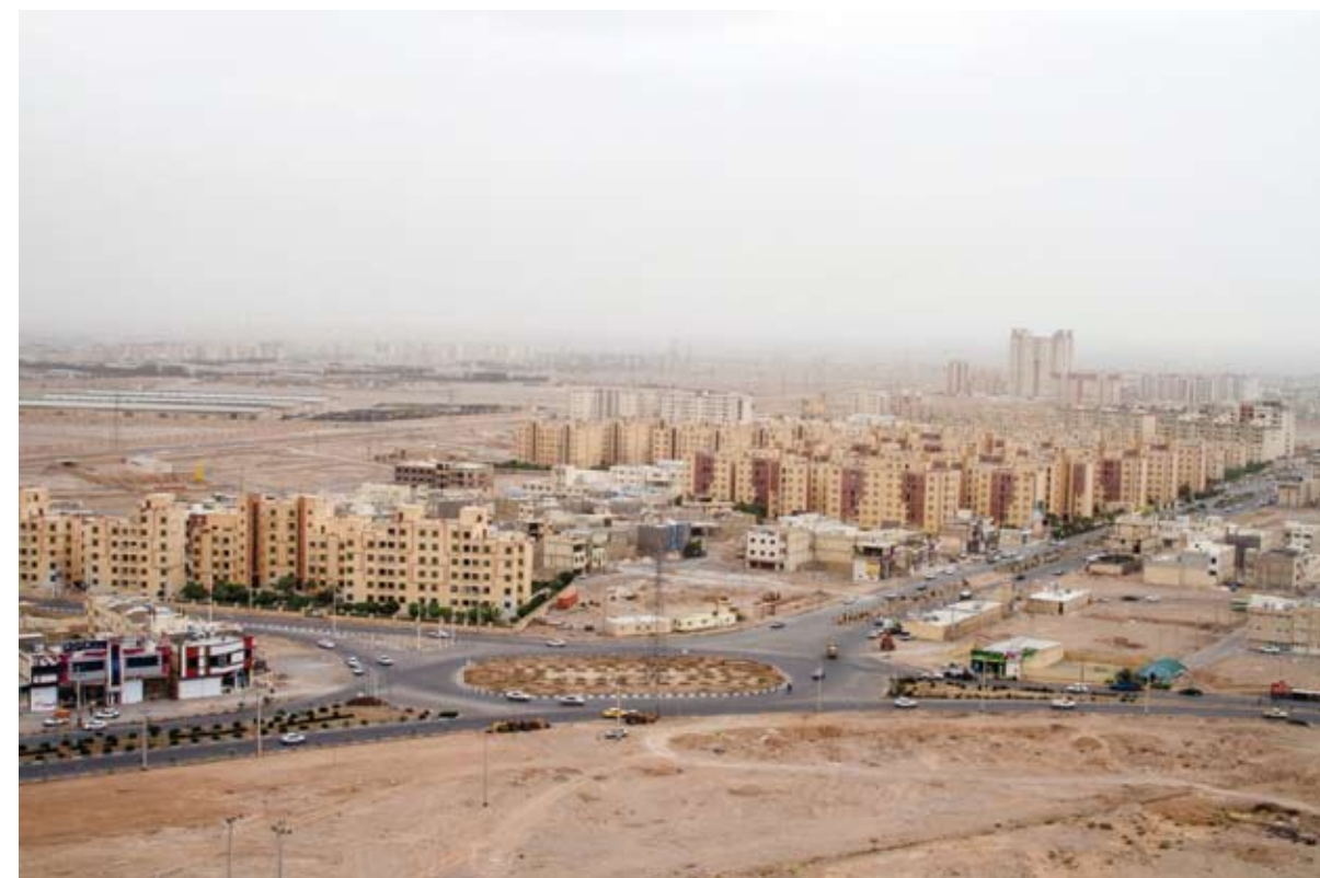
PANELÁKY. V podobných nevábných sídlištích, jako je toto ve městě Yazd, zatím musí bydlet velká část Íránců.
