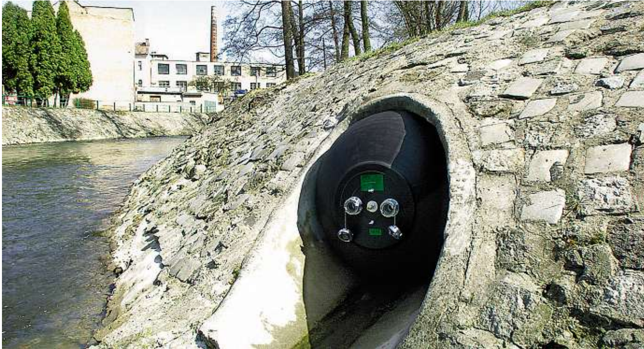
Použití těsnícího vaku z firmy Vapo při zábraně kontaminaci řeky znečištěnou odpadní vodou. FOTO: VAPO
