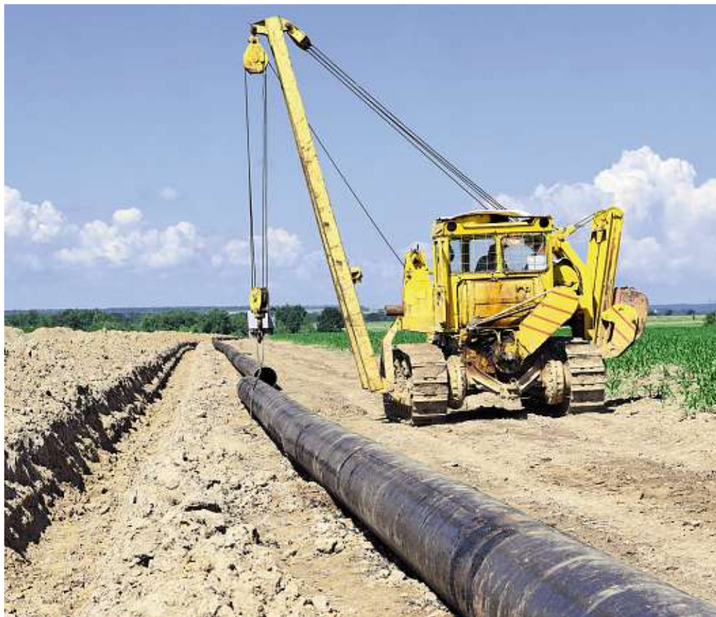
Prioritou je v Ázerbájdžánu výstavba jižního plynového koridoru. Jde o projekt v hodnotě kolem 40 miliard dolarů. Celá přepravní trasa má být uvedena do provozu v roce 2020. FOTO: SHUTTERSTOCK
