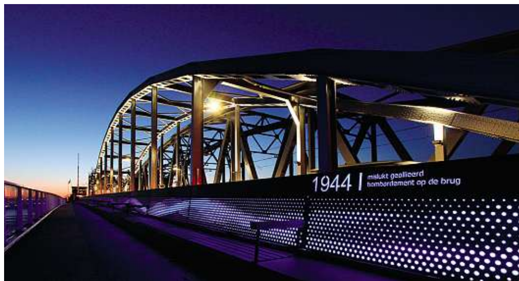
V nizozemském městě Zutphen řídí Tecomat Foxtrot efektní osvětlení mostu, který se Spojenci v roce 1944 neúspěšně pokusili zničit. FOTO: ARCHIV TECO
