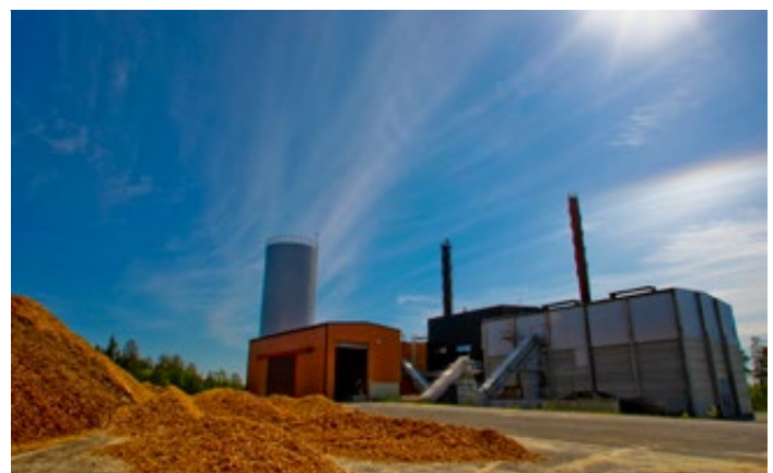
Vattenfall / CC BY
