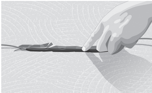
Kuva 3. Ura kylmä- ja lämmityskaapelin liitosta varten
