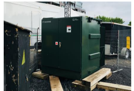
Borne temporaire pour alimenter le site en électricité avec Hydro-Québec
