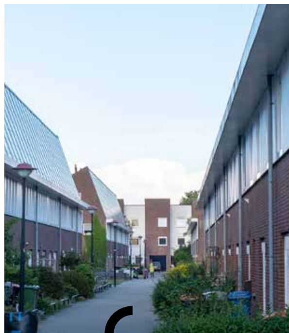
Er zijn al veel woningen met zonnepanelen op het dak in de nieuwere wijken, zoals Vathorst.
