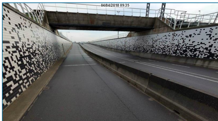
Figuur 3.6: Tunnelbak spoorlijn Alkmaar-Den Helder.
