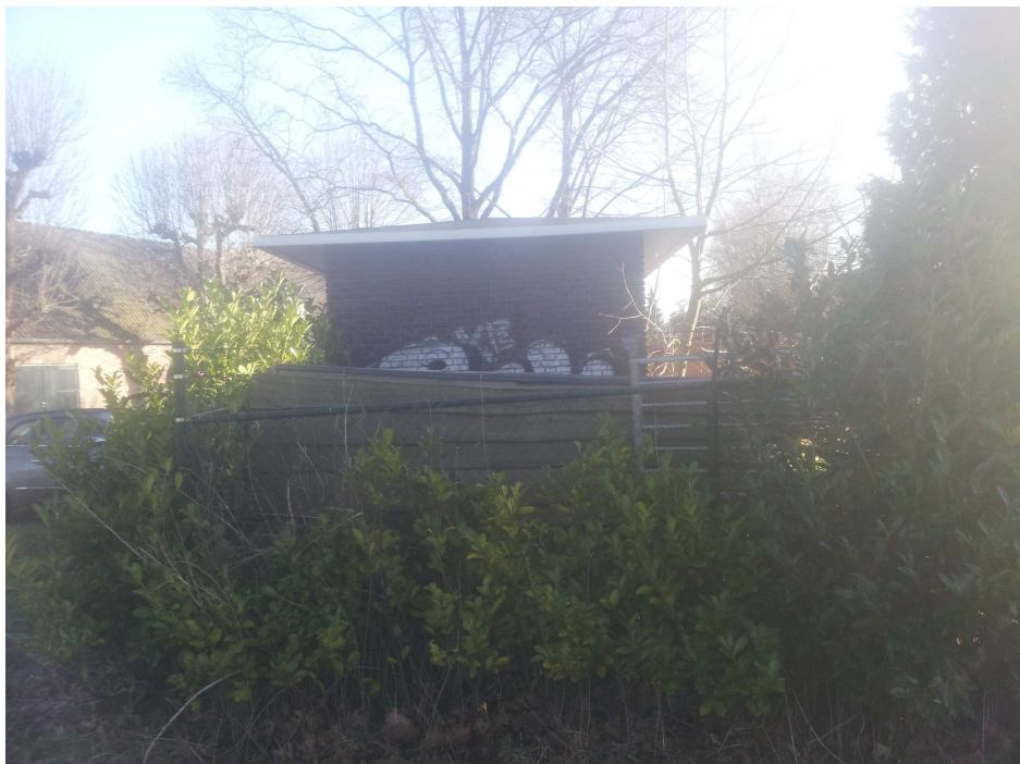
Afbeelding 2: Het elektriciteitshuisje met afscheiding
