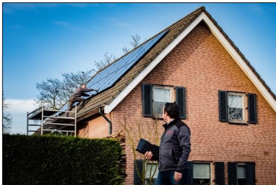
Zonnepanelen op daken
