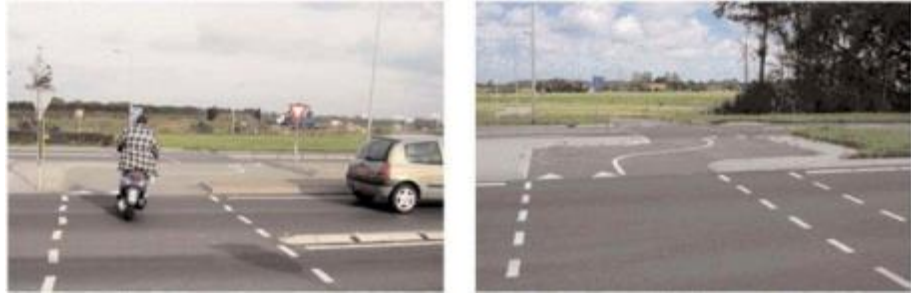
Figuur 11. Fietsoversteek met een chicane in brede middenberm (7 m). (bron: CROW, 2008; Figuren 51 en 52)
