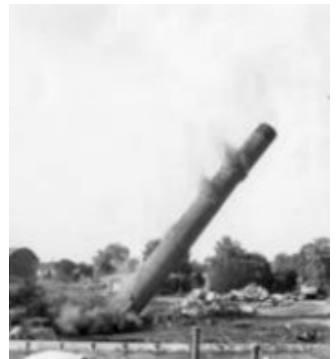
de laatste schoorsteen valt
