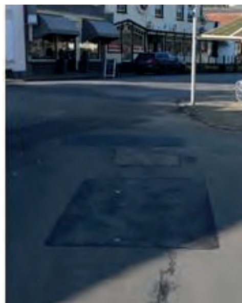
De VVD gaat de slechte wegen en losliggende stoeptegels aanpakken.
