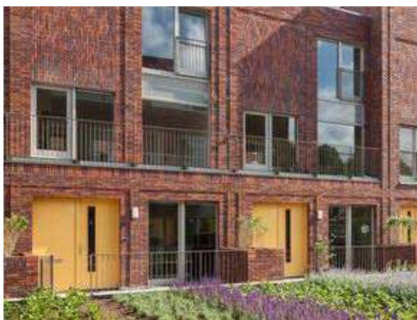
Set-back met transparant hekwerk verlaagt visueel de bebouwingshoogte
