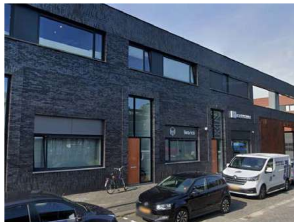
Bedrijfsruimte en woningen vormgegeven als geheel
