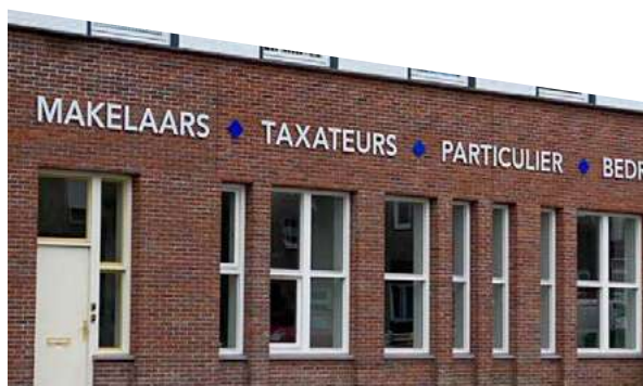
In de gevel geïntegreerde reclame uitingen
