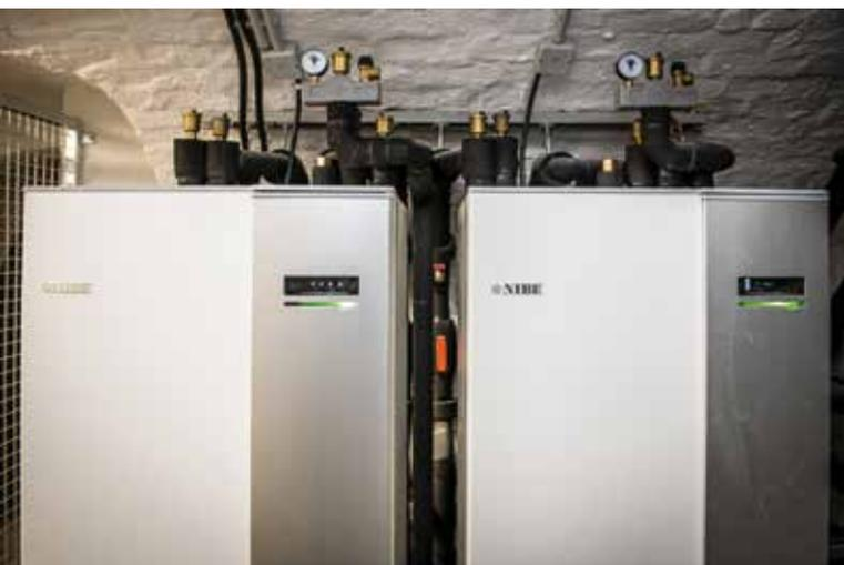
Zwei Nibe-Wärmepumpen vom Typ „F1145“, die im Kaskadenbetrieb laufen, wurden im Keller des Hauses auf engem Raum montiert.
