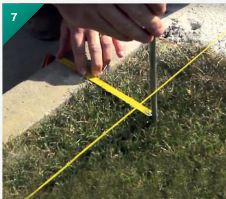
7. Pour garantir l'alignement des poteaux suivants.
