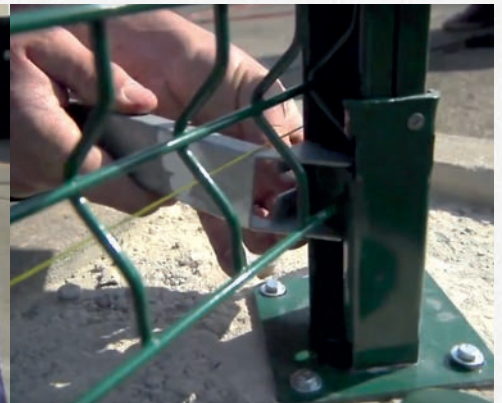
11. Rapprochez le panneau au premier poteau et fixez-le avec les clips en vous servant de la pince, sans avoir besoin d'autres outils ou vis.
