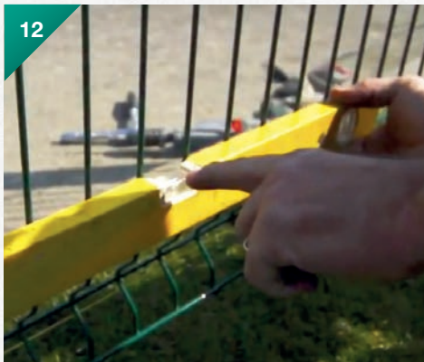
12. Contrôlez l'horizontalité du panneau et fixez-le au poteau suivant.
