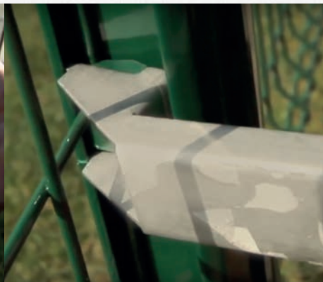
12. Contrôlez l'horizontalité du panneau et fixez-le au poteau suivant.
