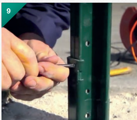
9. Bloquez le poteau et la platine avec une vis auto-taraudeuse.
