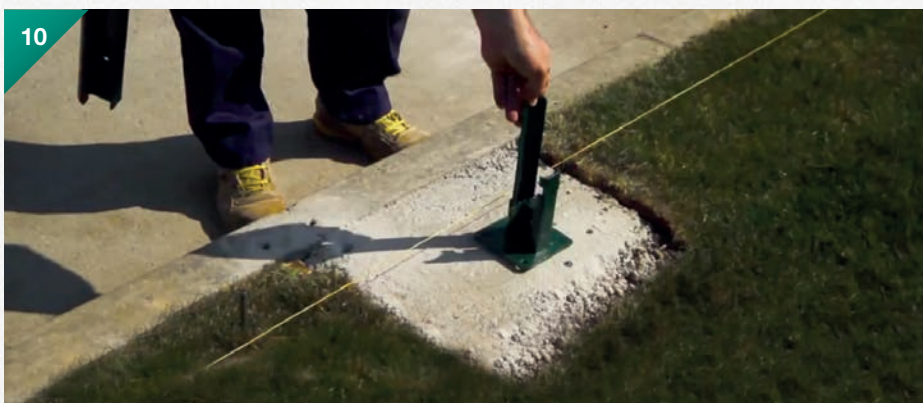
10. Insérez le poteau suivant dans la platine correspondante.
