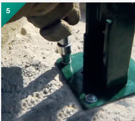
5. Insérez les chevilles à expansion et vissez-les sans serrer.
