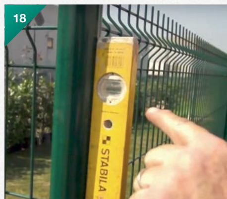
18. Vérifiez la verticalité des poteaux à l'aide d'un niveau et serrez convenablement les chevilles.
