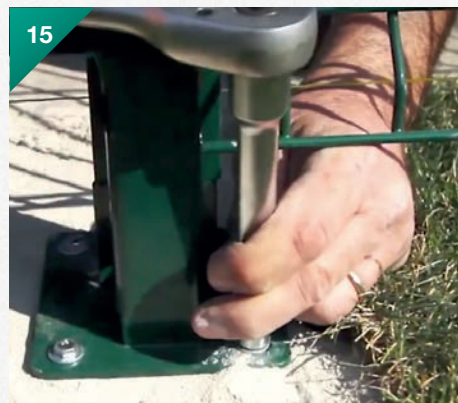
15. Insérez le chevilles à expansion et vissez-les sans serrer.
