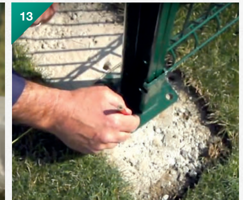
13. Réalisez quatre trous dans le points de fixation de la platine
