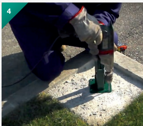
4. Réalisez quatre trous dans les points de fixation de la platine.
