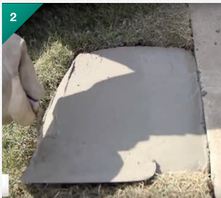
2. Remplissez les trous avec du ciment.
