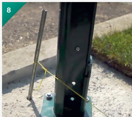
8. Insérez le poteau dans le profil.
