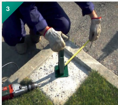
3. Quand le ciment se sera solidifié, place le premier poteau de la clôture.
