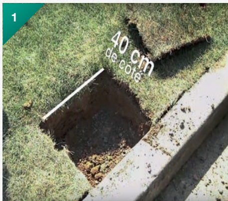
1. Préparez les trous de scellement d'environ 40 cm de profondeur.
