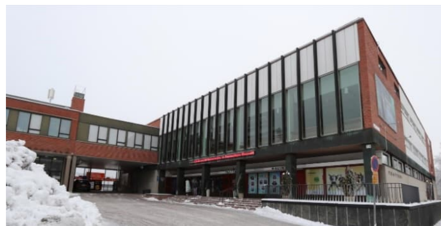
Kuva 7. Teatterirakennus ulkoa. (Kouvolan kaupunki 2023)
