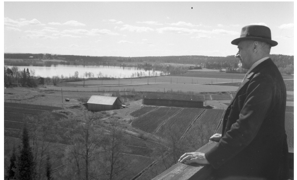
Vuodelta 1946 maisemakuva Ylöjärven kirkon tornista etelään. Kuvan keskivaiheilla näkyy Pöyhönoja. Vaaleakattoinen lato on nykyisen Räikäntornin kohdalla. Latojen takana erottuu alkuperäinen vanha Kuruntie. (Ylöjärven Muisti /Vapriikin kuva-arkisto)
