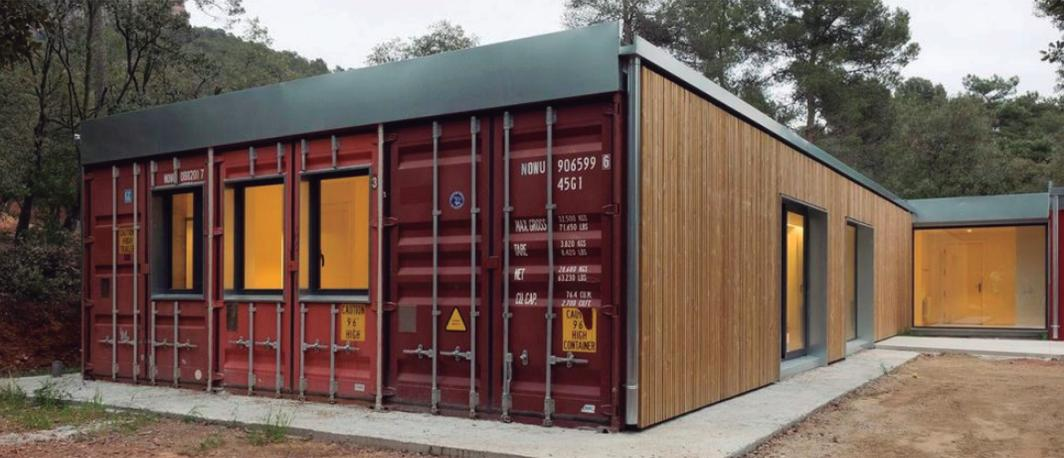
Los huecos abiertos deben mantener unas dimensiones y proporciones determinadas, para evitar la aparición de deformaciones. Por ese motivo hay que estudiar previamente el diseño, y hacer un reparto de huecos correcto que garantice la estabilidad estructural.
