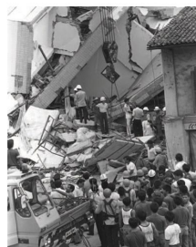
< 1986년 리안약 빌딩 붕괴, 33명 사망 >
