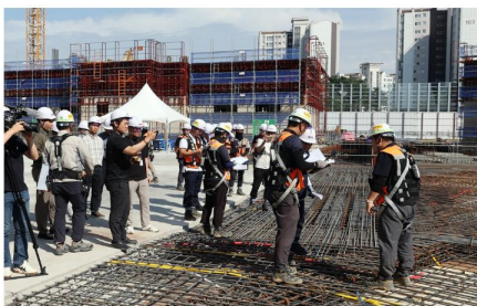
서울주택도시공사, 고덕강일 2단지 공사현장 점검
