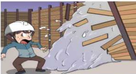
지반 연약화로 인한 흙막이 지보공 무너짐
