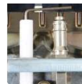
ODS Sistema de seguridad por ausencia de oxígeno.
