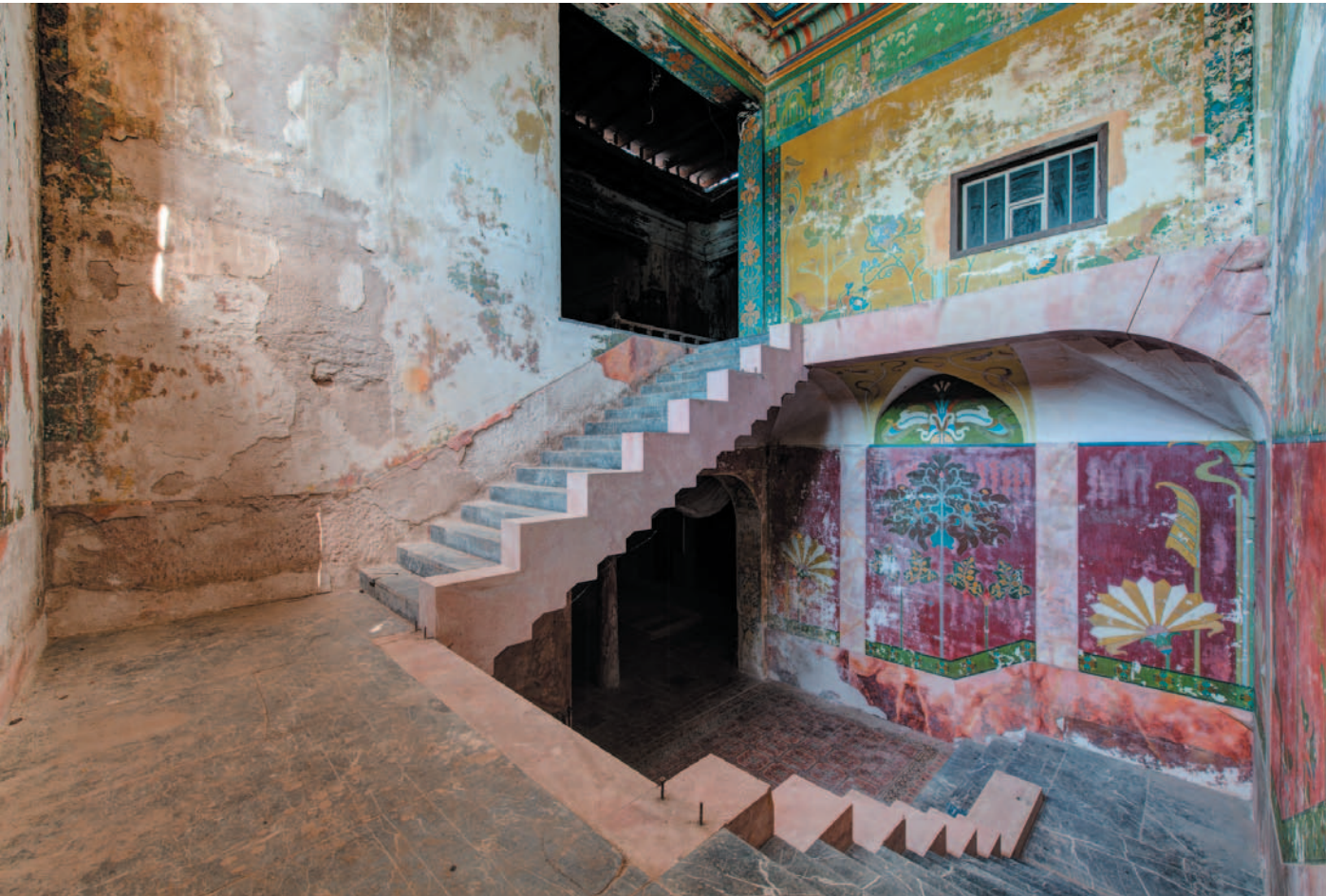
La cage d'escalier
