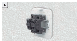
Aplicación del mecanismo a la pared
