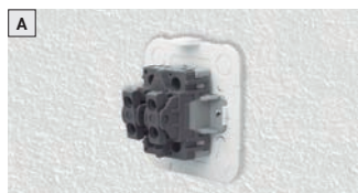
Application du mécanisme sur le mur
