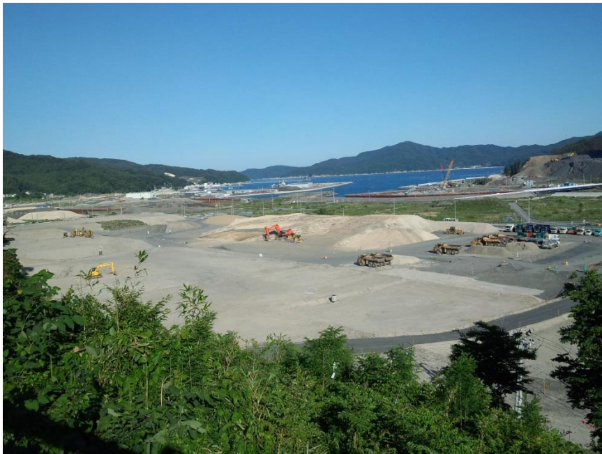
大槌町中央公民館から見た街、漸く更地になった状態。
