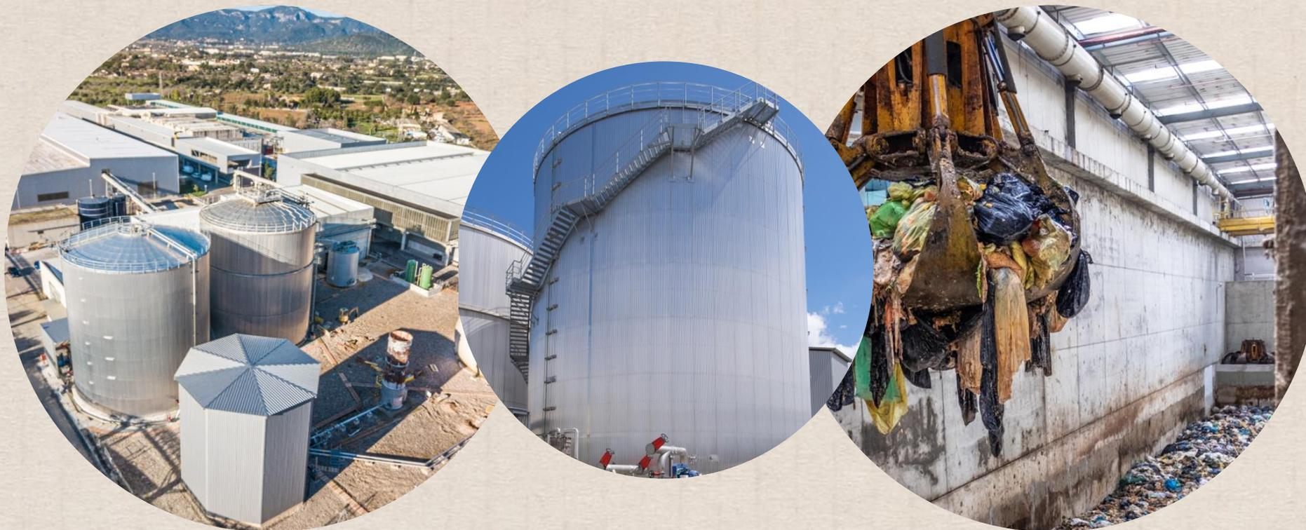
Mediante el **proceso de metanización**, los residuos orgánicos (FORM y lodos) se transforman en biogás con el que generamos energía renovable.
