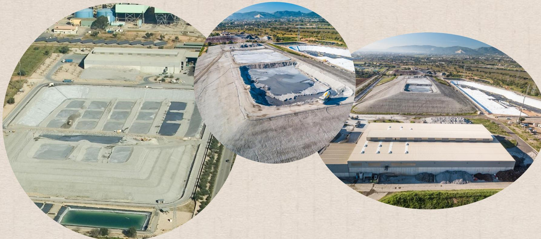
Nuestro **depósito de seguridad** recibe los residuos de depuración de gases producidos durante el proceso de valorización energética, una vez han sido estabilizados mezclándolos con cemento y agua.
