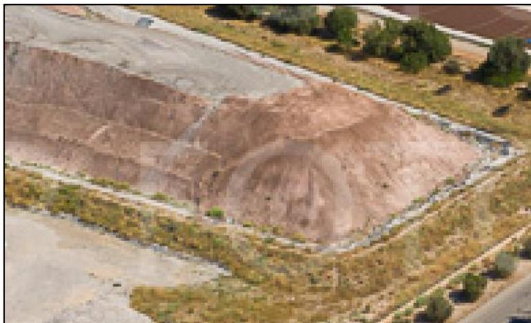
Tanto en DS como en DRZ2, la pendiente de las canales de hormigón en taludes ronda el 30%.
